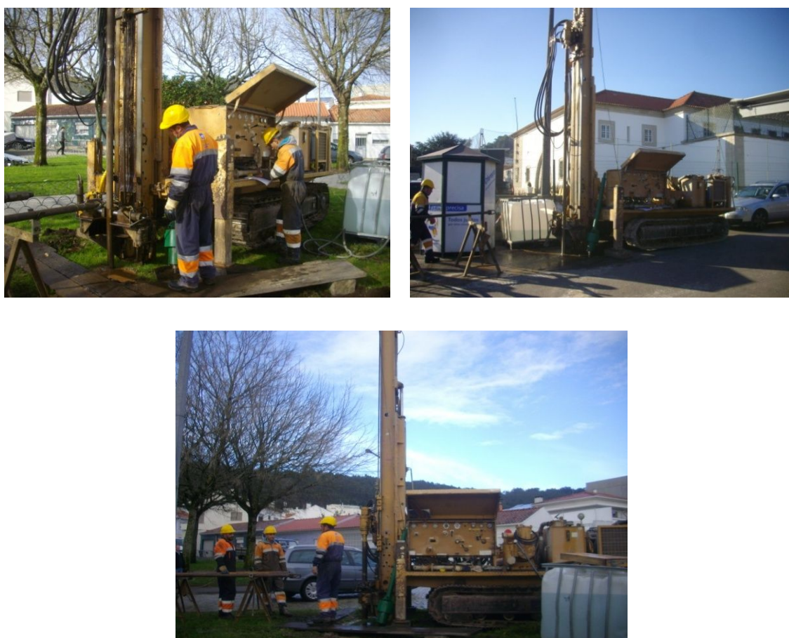
Figura 9 – Execução das sondagens.
