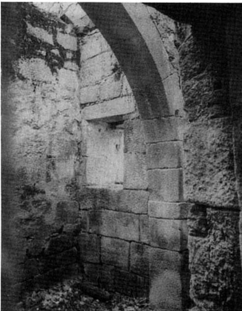
Fig. 23 — Articulação do arco com a parede.
