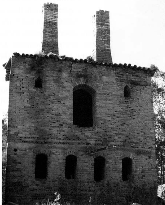
Forno industrial de telha e tijolo. Fábrica Gonçalves, Lda., Fabril do Barreiro.
