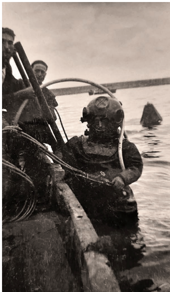
Domingos Teixeira operando oxi-corte, [s.d.], local desconhecido – Foto dos herdeiros de Domingos Teixeira
