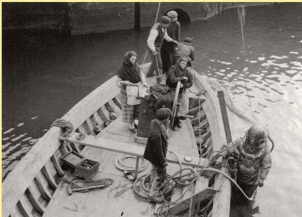
Viana do Castel, janeiro de 1934, no canal, junto às portas da eclusa – Arquivo fotográfico da APDL, S.A.
